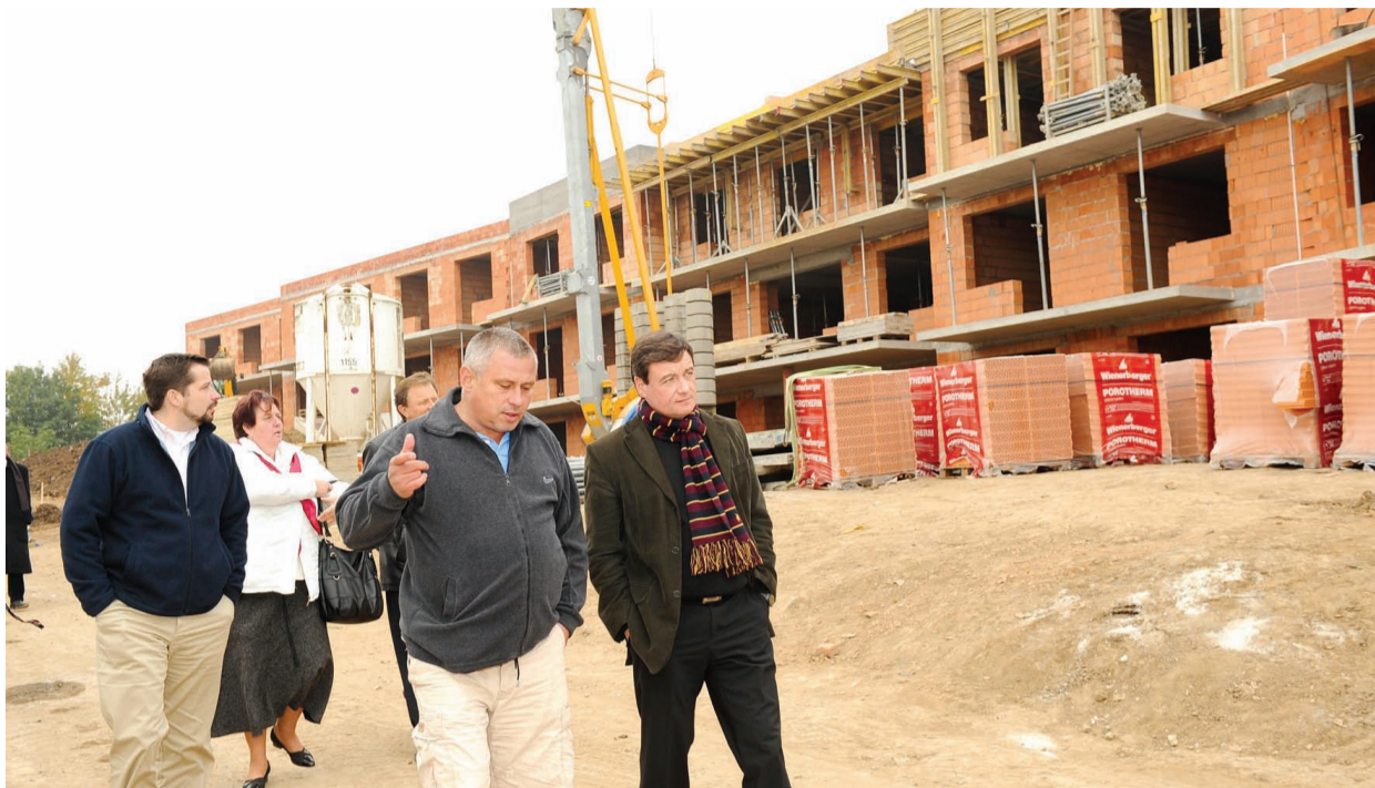
Zástupce zhotovitele stavby Ing. Vladimír Kočí provádí stavbu středočeského hejtmána MUDr. Davida Ratha a vedoucího odboru sociálních věcí Davida Grunthala (vzadu vlevo).
